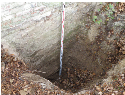
ODKRYWKA FUNDAMENTÓW
